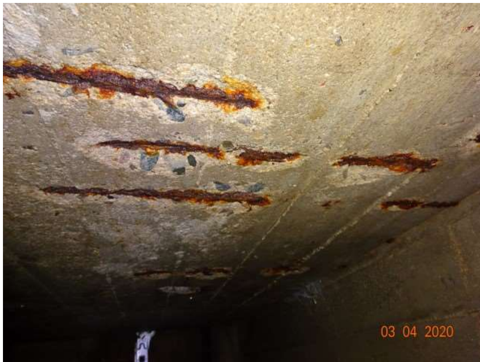
Stropní deska se silně korodující výztuží
