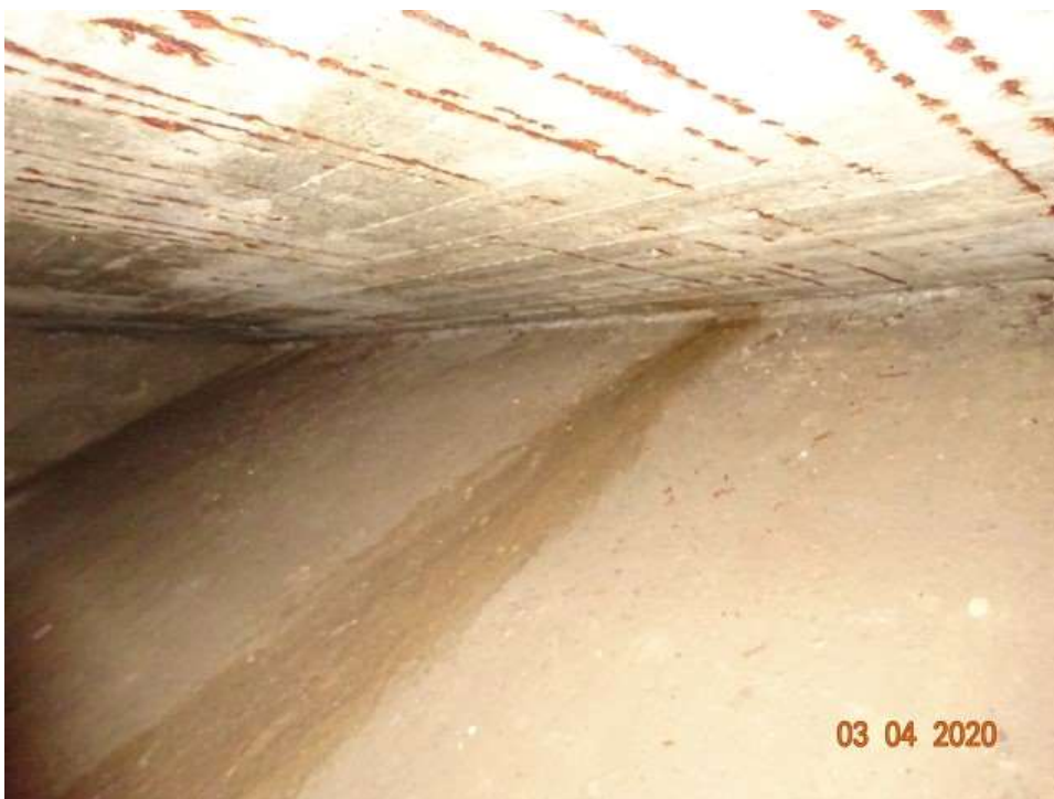
Horní část skrytého pole – průsaky ve spáře na straně MZ a obnažená výztuž stropní desky
