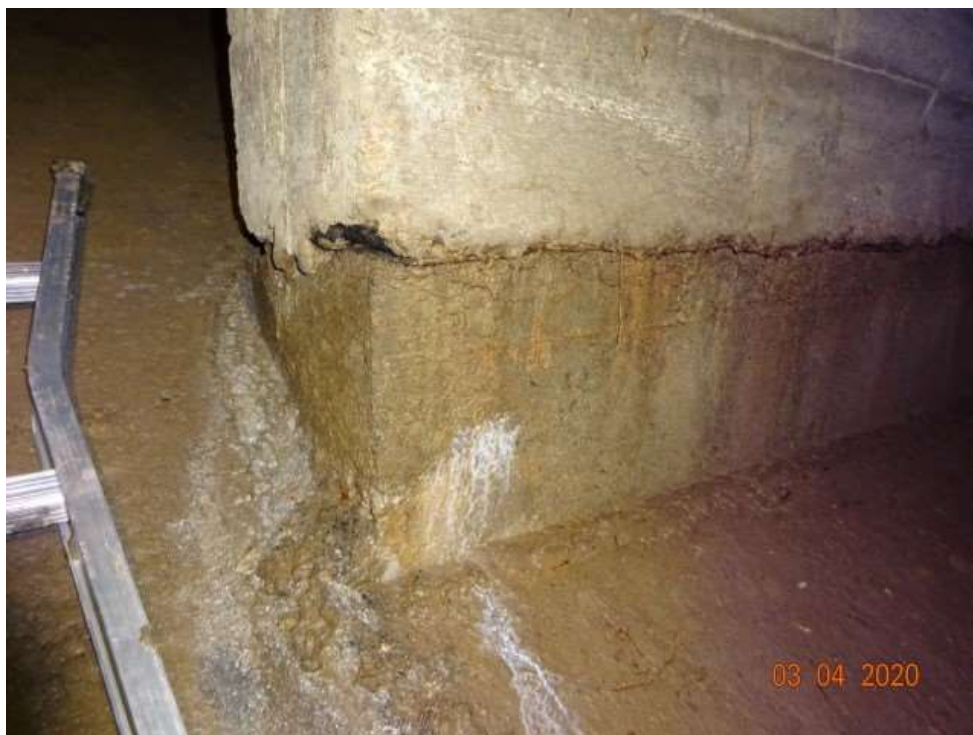
Detail uložení střední stěny na lepenku
