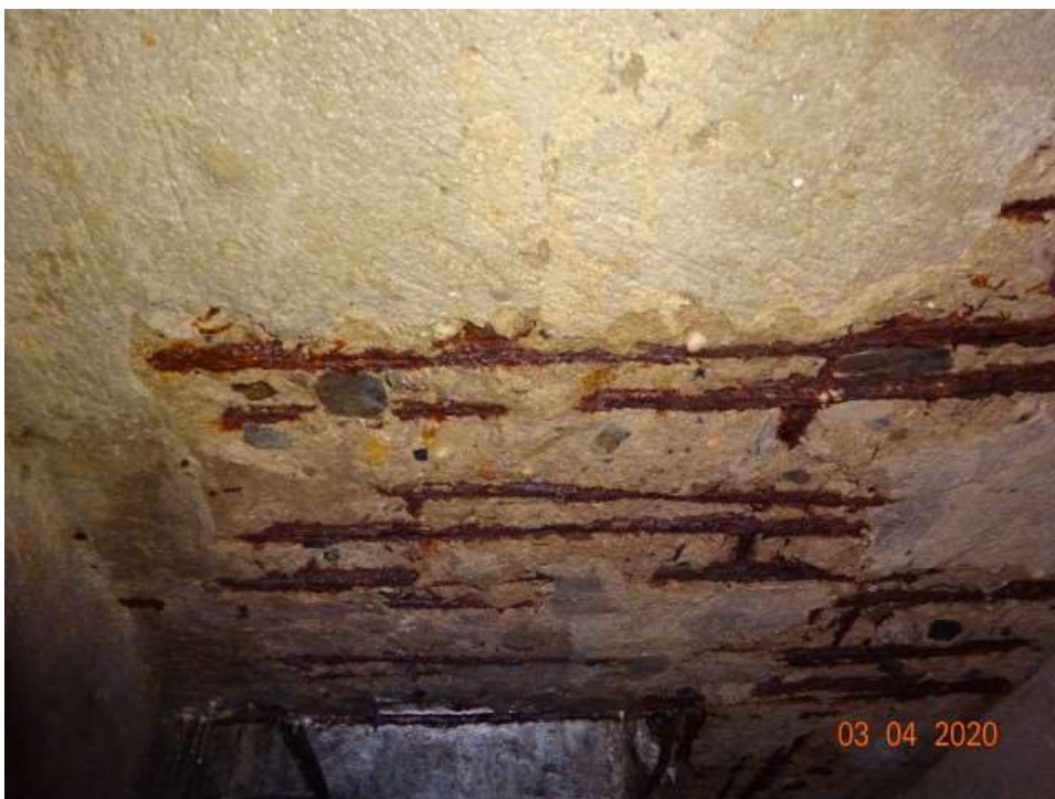
Stropní deska se silně korodující výztuží
